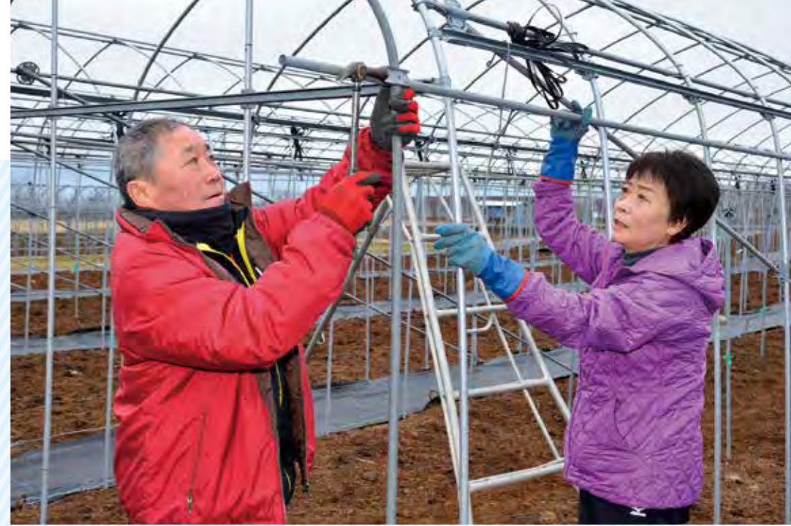
アスパラガスハウスの骨組み補強
